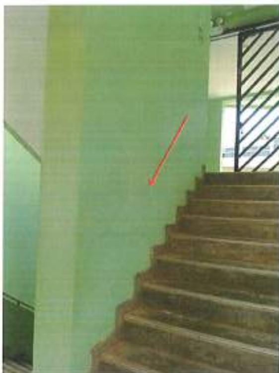
Fotografía 5. Escalera en U Bloque B-11 (Edificio 05).
