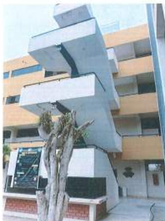
Fotografía 13. Escalera Bloque B-39 (Edificio 10).
