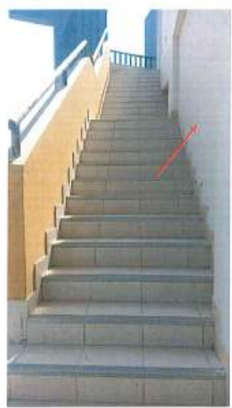
Fotografía 15. Escalera Lineal 2 del bloque B-20 (Edificio 11).
