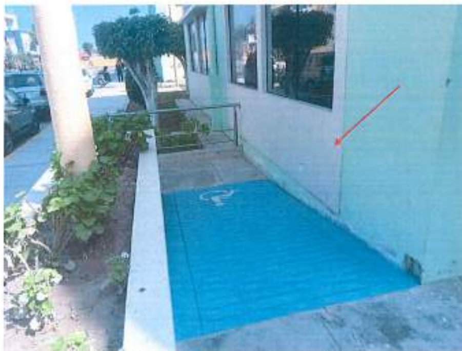
Fotografía 6. Rampas Entrada Bloque B-11 (Edificio 05).
