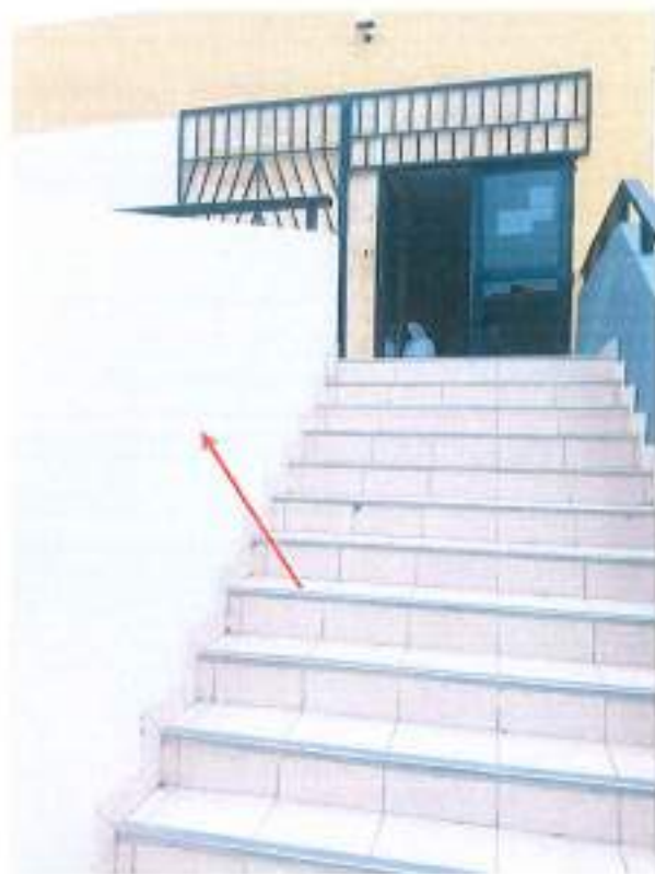
Fotografía 19. Escalera en U Bloque B-32 (Edificio 14)
