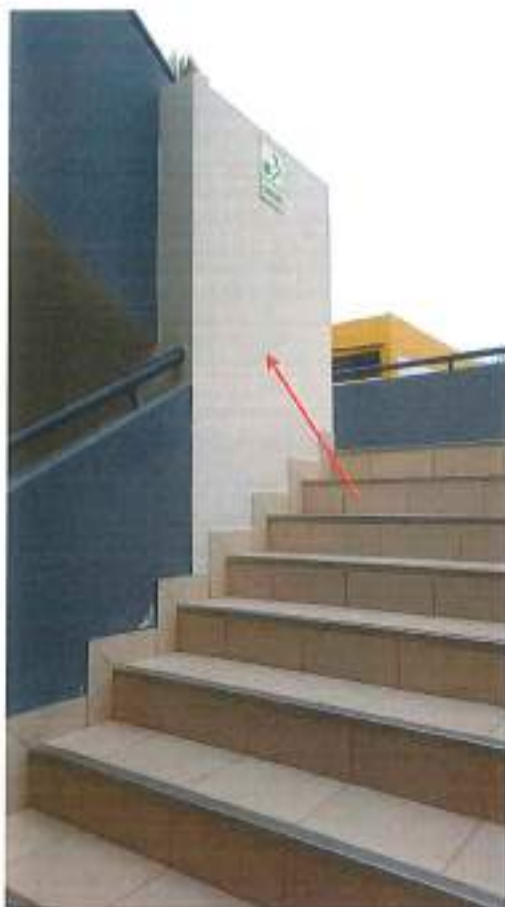
Fotografía 17. Escalera en U Bloque B-05 (Edificio 12).
