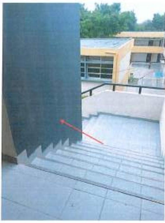
Fotografía 11. Escalera Exterior Pasamano Central Bloque B-31 (Edificio 9)
