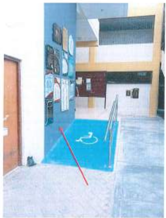
Fotografía 1. Entrada Auditorio FICSA (Edificio 1).
