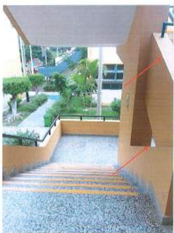
Fotografía 9. Escalera Bloque B-04 (Edificio 08).
