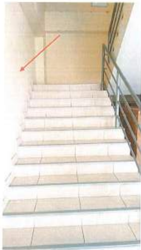
Fotografía 7. Escalera en U Bloque B-52 (Edificio 6).
