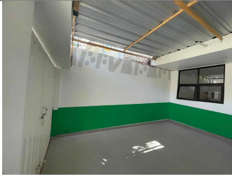
Vista del Hall de ingreso vista lateral izquierdo
