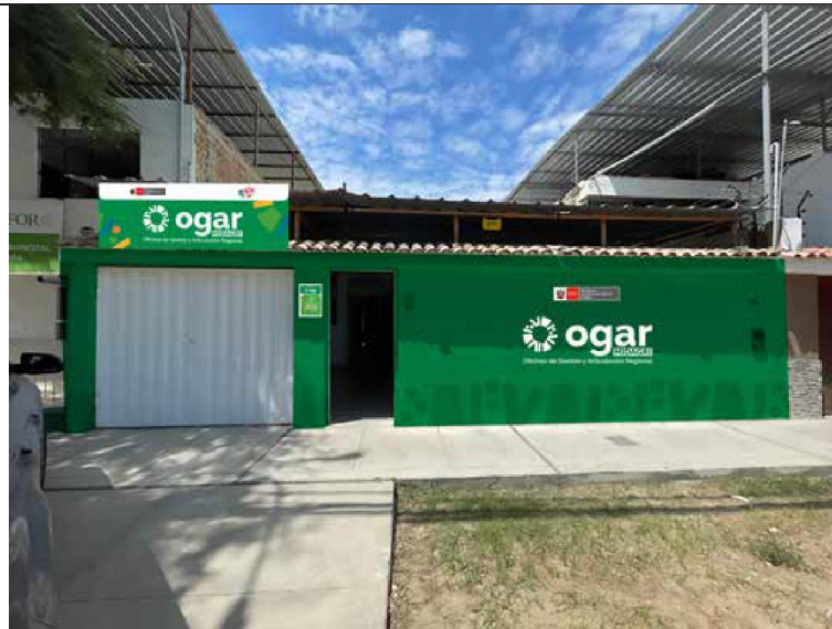
Vista de la Fachada principal
