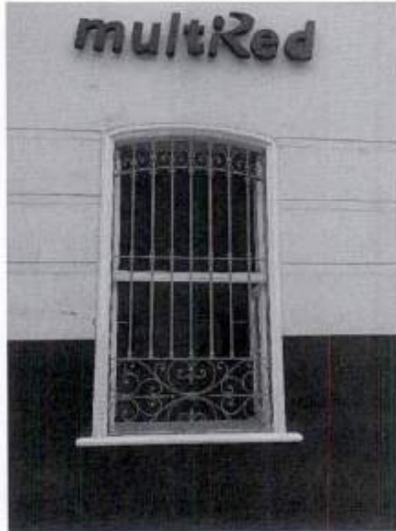
Foto 12 pintado de ventanas de la fachada
