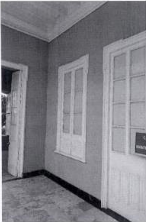
Foto 11 Pintado de puertas, ventanas y Molduras de madera en cielo raso
