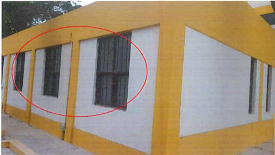
Fotografía 6. Cambio de ventanas existentes de altura 1.60m por nuevas ventana sistema corredizo con marco de aluminio.
