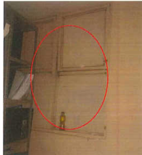
Fotografía 1,2. Cambio de ventanas existentes de dimensiones (1.20x1.50) por nuevas ventana sistema corredizo con marco de aluminio.
