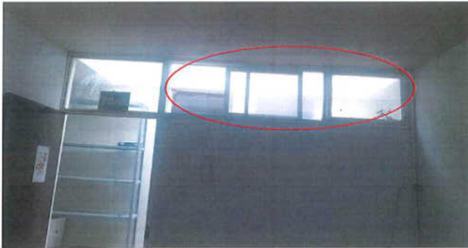
Fotografía 5. Cambio de ventanas existentes de dimensiones (2.25x0.60) por nuevas ventana sistema corredizo con marco de aluminio.
