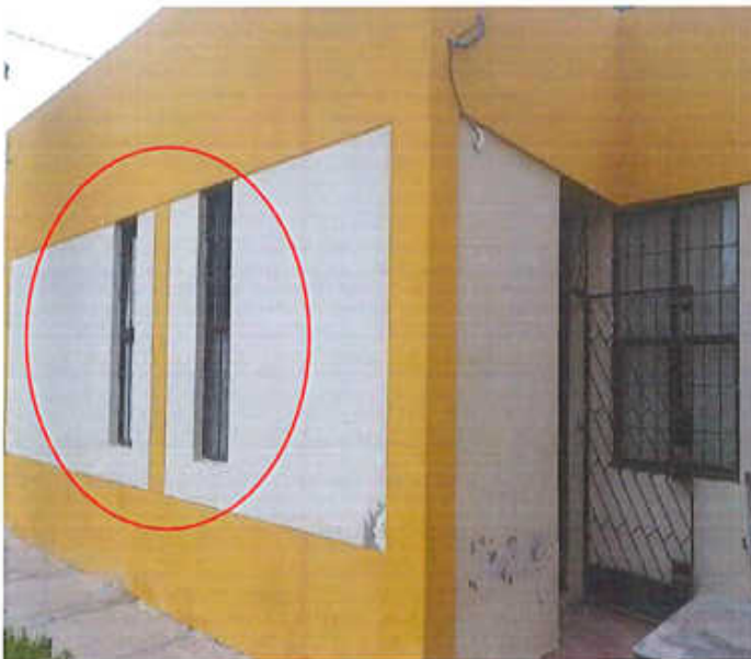
Fotografía 3,4. Cambio de ventanas existentes de dimensiones (0.62x1.60) y (0.57x1.68) por nuevas ventana sistema batiente 2 hojas con marco de aluminio.
