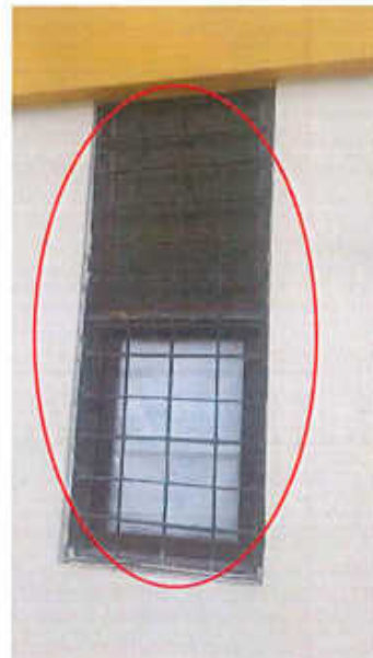
Fotografía 3,4. Cambio de ventanas existentes de dimensiones (0.62x1.60) y (0.57x1.68) por nuevas ventana sistema batiente 2 hojas con marco de aluminio.
