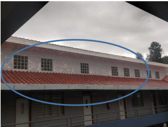
FACHADA SUPERIOR CONTIGUA A LOS TECHOS DE LA SEDE, EXISTIENDO DESGASTE, EROSION DE LA PINTURA ACTUAL Y POR ENDE EXPOSICION A LA HUMEDAD EN TEMPORADA DE LLUVIAS
