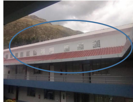
FACHADA SUPERIOR CONTIGUA A LOS TECHOS DE LA SEDE, EXISTIENDO DESGASTE, EROSION DE LA PINTURA ACTUAL Y POR ENDE EXPOSICION A LA HUMEDAD EN TEMPORADA DE LLUVIAS
