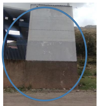
FACHADA DEL PERIMETRO EXTERIOR DE LA SEDE, EXISTIENDO DESGASTE, EROSION DE LA PINTURA ACTUAL Y POR ENDE EXPOSICION A LA HUMEDAD EN TEMPORADA DE LLUVIAS
