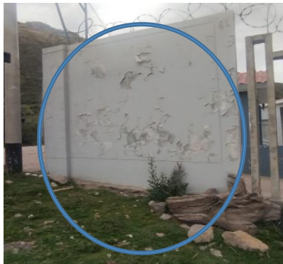
FACHADA DEL PERIMETRO EXTERIOR DE LA SEDE, EXISTIENDO DESGASTE, EROSION DE LA PINTURA ACTUAL Y POR ENDE EXPOSICION A LA HUMEDAD EN TEMPORADA DE LLUVIAS
