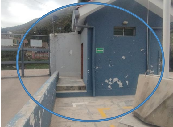
FACHADA DE LAS OFICIAS UBICADAS AL INGRESO DE LA SEDE, EXISTIENDO DESGASTE, EROSION DE LA PINTURA ACTUAL Y POR ENDE EXPOSICION A LA HUMEDAD EN TEMPORADA DE LLUVIAS
