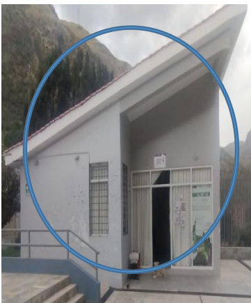
FACHADA DE LAS OFICIAS UBICADAS AL INGRESO DE LA SEDE, EXISTIENDO DESGASTE, EROSION DE LA PINTURA ACTUAL Y POR ENDE EXPOSICION A LA HUMEDAD EN TEMPORADA DE LLUVIAS
