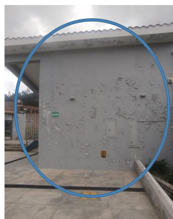
FACHADA DE LAS OFICIAS UBICADAS AL INGRESO DE LA SEDE, EXISTIENDO DESGASTE, EROSION DE LA PINTURA ACTUAL Y POR ENDE EXPOSICION A LA HUMEDAD EN TEMPORADA DE LLUVIAS
