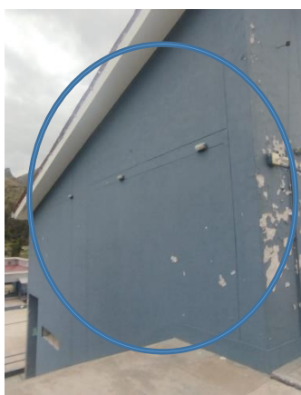
FACHADA DE LAS OFICIAS UBICADAS AL INGRESO DE LA SEDE, EXISTIENDO DESGASTE, EROSION DE LA PINTURA ACTUAL Y POR ENDE EXPOSICION A LA HUMEDAD EN TEMPORADA DE LLUVIAS
