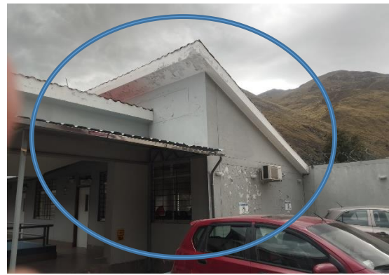
FACHADA DE LAS OFICINAS EN EL PERIMETRO DE COCHERA DE LA SEDE, EXISTIENDO DESGASTE, EROSION DE LA PINTURA ACTUAL Y POR ENDE EXPOSICION A LA HUMEDAD EN TEMPORADA DE LLUVIAS
