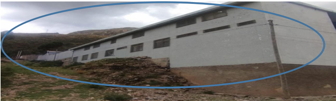
FACHADA DE LAS OFICIAS UBICADAS AL INGRESO DE LA SEDE, EXISTIENDO DESGASTE, EROSION DE LA PINTURA ACTUAL Y POR ENDE EXPOSICION A LA HUMEDAD EN TEMPORADA DE LLUVIAS
