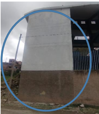
FACHADA DEL PERIMETRO EXTERIOR DE LA SEDE, EXISTIENDO DESGASTE, EROSION DE LA PINTURA ACTUAL Y POR ENDE EXPOSICION A LA HUMEDAD EN TEMPORADA DE LLUVIAS
