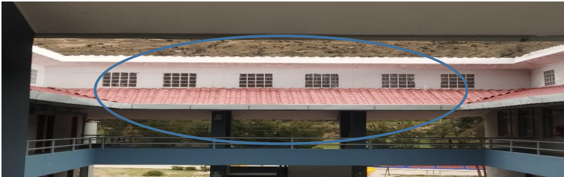
FACHADA CONTIGUA A LAS BARANDAS DE TRANSITO DE LA SEDE, EXISTIENDO DESGASTE, EROSION DE LA PINTURA ACTUAL Y POR ENDE EXPOSICION A LA HUMEDAD EN TEMPORADA DE LLUVIAS
