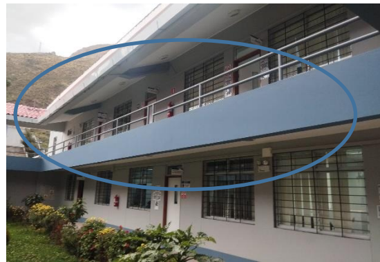
FACHADA CONTIGUA A LAS BARANDAS DE TRANSITO DE LA SEDE, EXISTIENDO DESGASTE, EROSION DE LA PINTURA ACTUAL Y POR ENDE EXPOSICION A LA HUMEDAD EN TEMPORADA DE LLUVIAS
