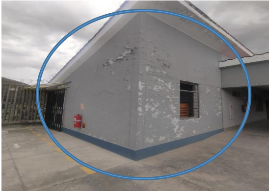
FACHADA DE LAS OFICINAS EN EL PERIMETRO DE COCHERA DE LA SEDE, EXISTIENDO DESGASTE, EROSION DE LA PINTURA ACTUAL Y POR ENDE EXPOSICION A LA HUMEDAD EN TEMPORADA DE LLUVIAS
