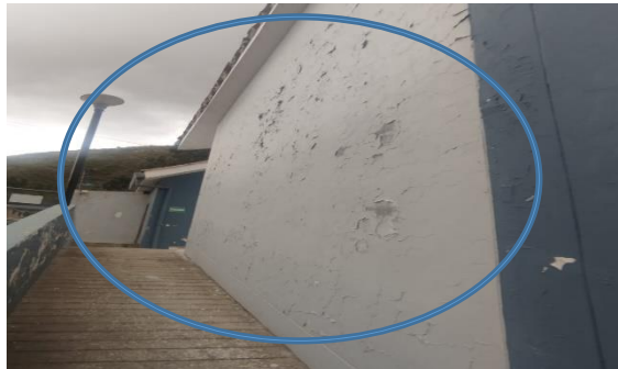
FACHADA DE LOS ACCESOS Y OFICINAS DE LA SEDE, EXISTIENDO DESGASTE, EROSION DE LA PINTURA ACTUAL Y POR ENDE EXPOSICION A LA HUMEDAD EN TEMPORADA DE LLUVIAS
