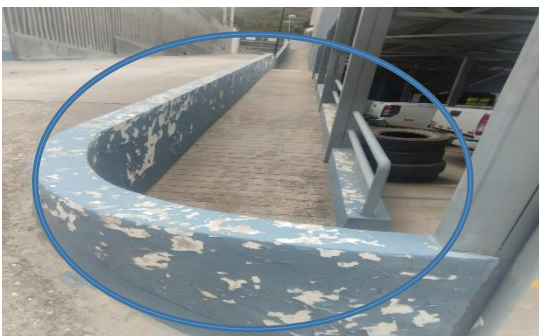
FACHADA DE LOS ACCESOS Y OFICINAS DE LA SEDE, EXISTIENDO DESGASTE, EROSION DE LA PINTURA ACTUAL Y POR ENDE EXPOSICION A LA HUMEDAD EN TEMPORADA DE LLUVIAS
