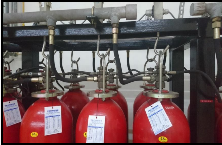
Conexión de los extintores al sistema
