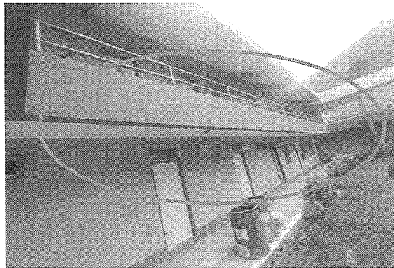
FACHADA CONTIGUA A LAS BARANDAS DE TRANSITO DE LA SEDE, EXISTIENDO DESGASTE, EROSION DE LA PINTURA ACTUAL Y POR ENDE EXPOSICION A LA HUMEDAD EN TEMPORADA DE LLUVIAS
