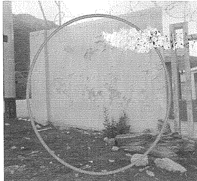
FACHADA DEL PERIMETRO EXTERIOR DE LA SEDE, EXISTIENDO DESGASTE, EROSION DE LA PINTURA ACTUAL Y POR ENDE EXPOSICION A LA HUMEDAD EN TEMPORADA DE LLUVIAS
