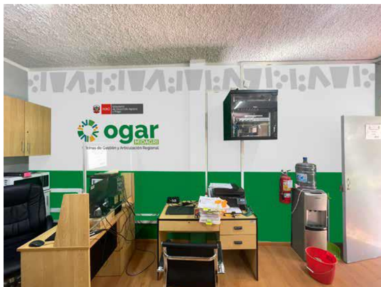
Vista del muro 01 interno de la Oficina 01
