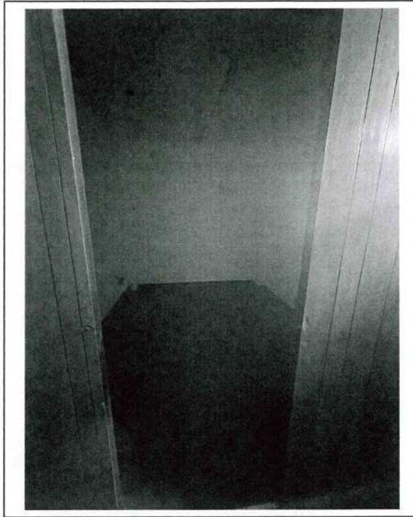
IMAGEN . MUROS DE DRYWALL EXISTENTES CON ACABADO DE LISTONES DE MADERA EN SEGUNDO NIVEL ZONA POSTERIOR.
