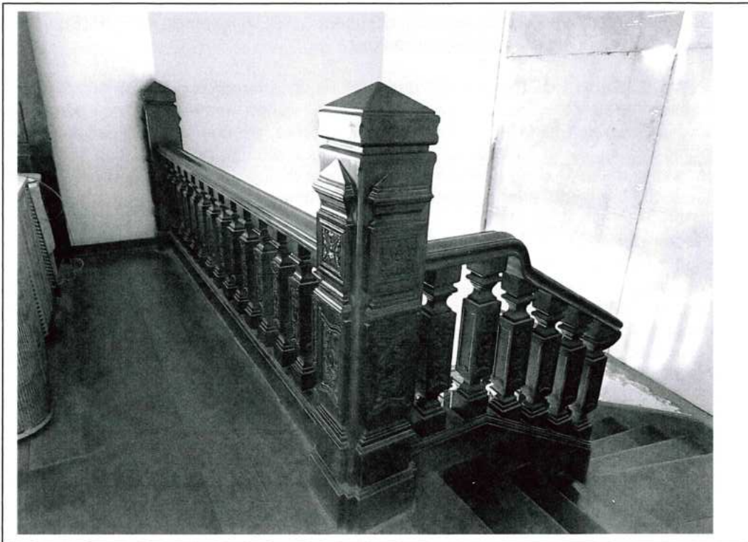
IMAGEN. ESCALERA PRINCIPAL DE MADERA CON BALAUSTRES , LLEGADA A SEGUNDO NIVEL
