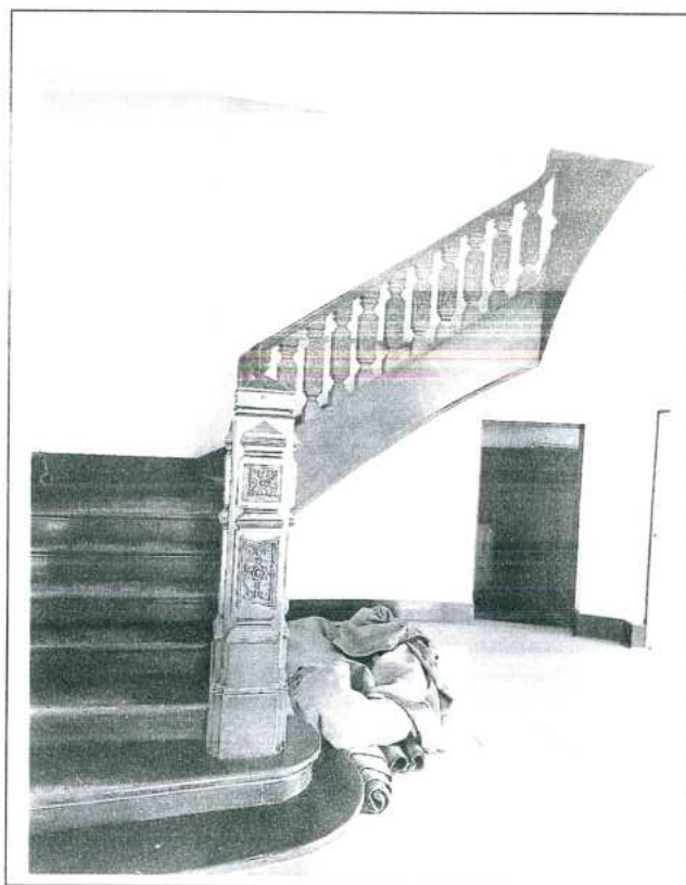
IMAGEN. ESCALERA PRINCIPAL DE MADERA EN PRIMER NIVEL
