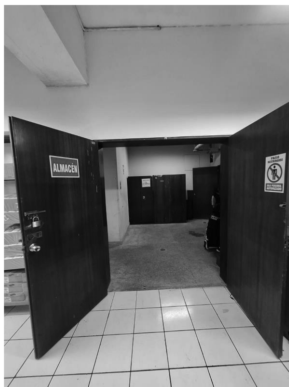
En la imagen se muestra el espacio en donde realiza la instalacion de la puerta corrediza metalica.
