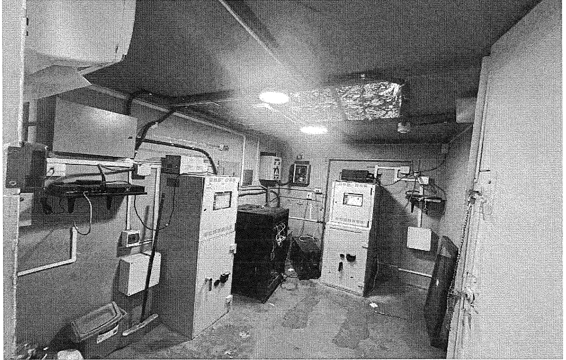
Imagen 4 y 5 : Recinto del ambiente de cajeros 1187 y 1908 (se desmontara los muros de drywall y el techo y se eliminara y se hará la demolición del piso de cemento pulido H=0.10m y se colocará porcelanato beige similar al existente).
