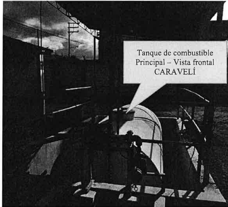
Tanque de combustible principal de Caravelí
