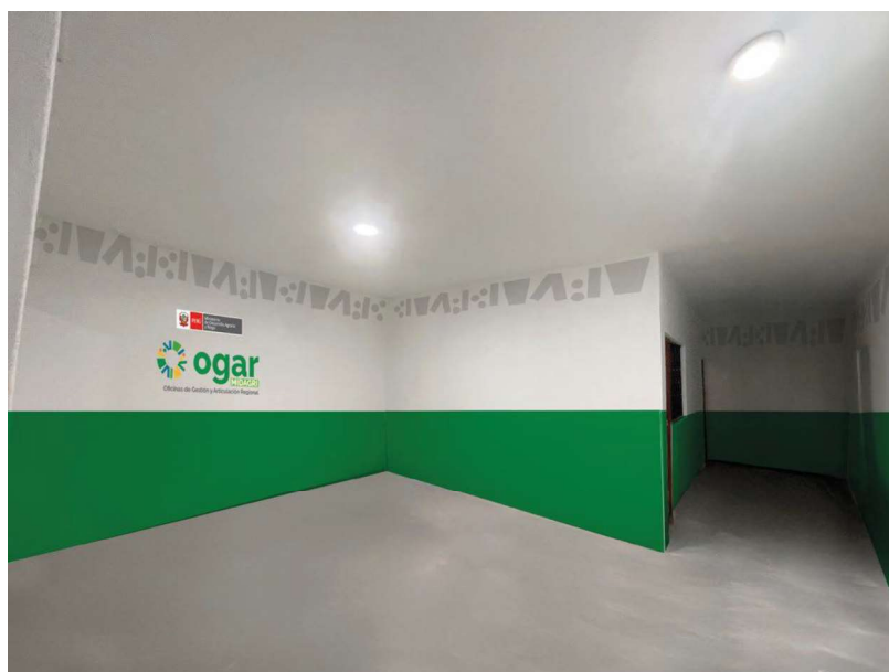
Vista de la Recepción
