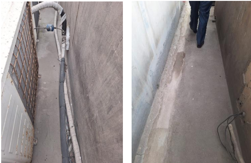
Imagen N°09: Para la ejecución de la partida de control de fisuras y de membrana líquida impermeabilizante se deberá de elevar los aires acondicionados y/o otros objetos que impidan la correcta ejecución de las partidas.
