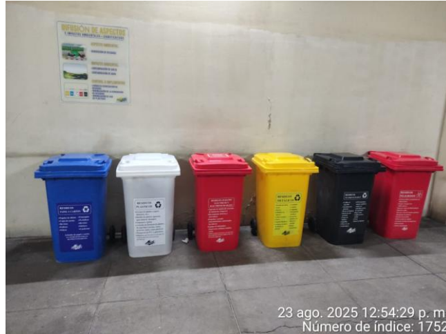
Imagen N°1: Almacén temporal de residuos sólidos ubicado en el túnel de la casa de máquinas de la central de Charcani V
