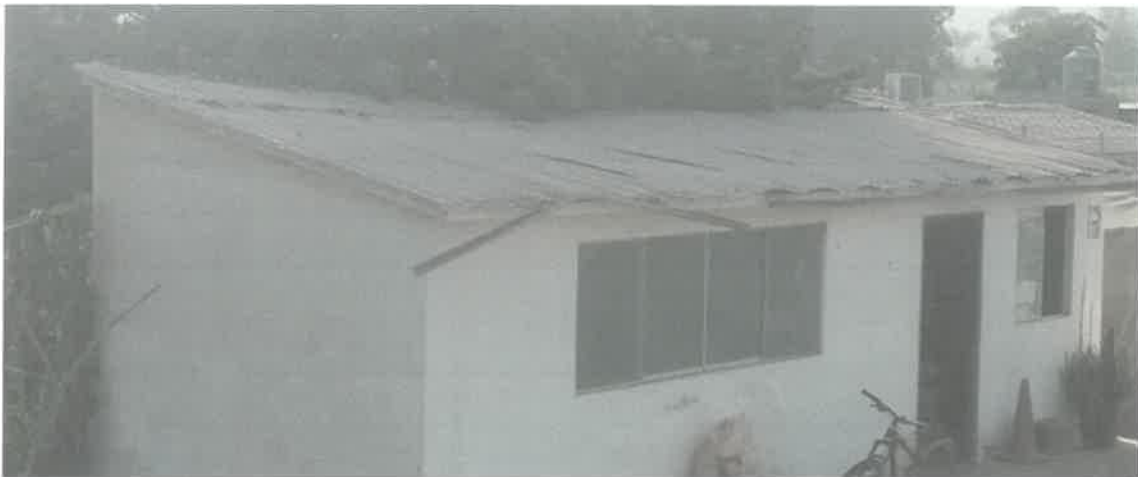
Fig. 4. Vista exterior del techo del área a acondicionar
