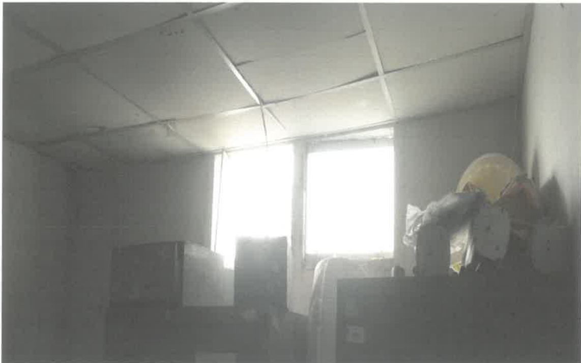
Fig. 2. Cieloraso y ventanas del ambiente
