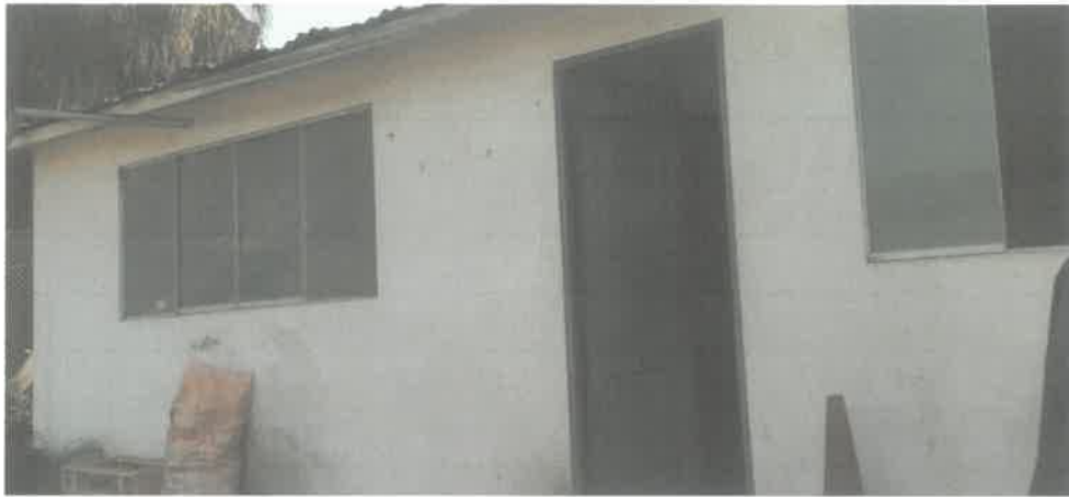
Fig. 1. Fachada del área a trabajar
