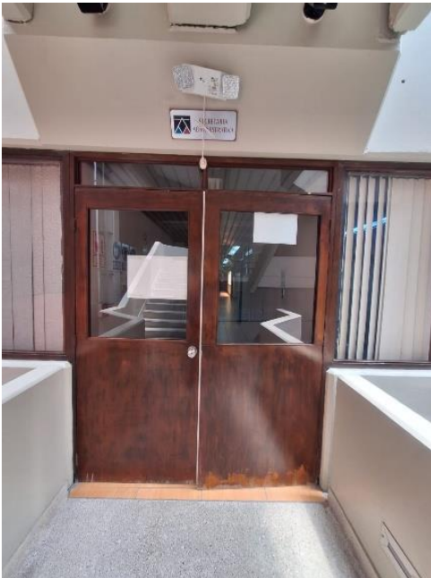
Imagen N°04: El proveedor previamente deberá de realizar la desinstalación de la puerta de madera y todos sus elementos. Se deberá de realizar el suministro e instalación de marco de perfil metálico de espesor mínimo 3.00 m, para que sirva de elemento de sujeción de la puerta de vidrio.
