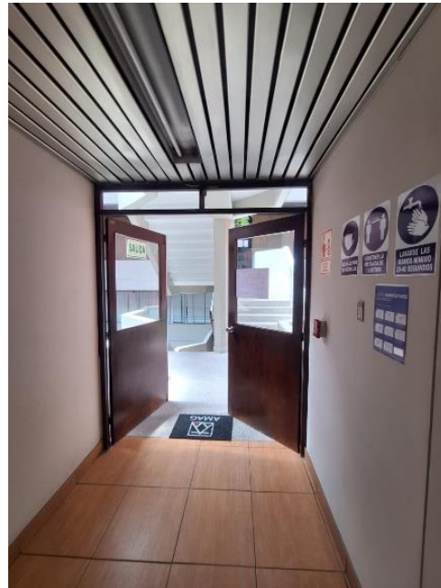
Imagen N°04: El proveedor previamente deberá de realizar la desinstalación de la puerta de madera y todos sus elementos. Se deberá de realizar el suministro e instalación de marco de perfil metálico de espesor mínimo 3.00 m, para que sirva de elemento de sujeción de la puerta de vidrio.
