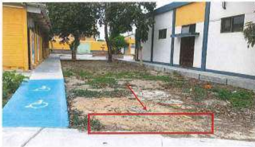
Fotografía 49. Contenedor N°49 de Residuos Sólidos. AUDITORIO UNPRG.
