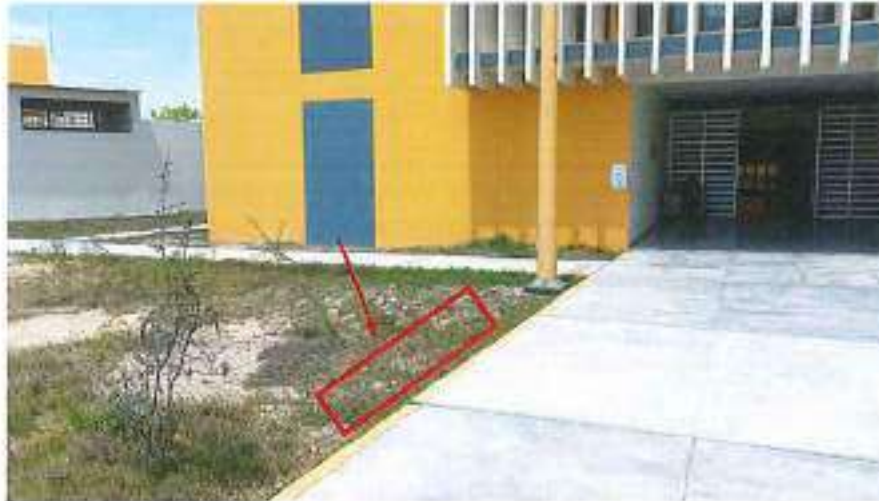
Fotografía 9. Contenedor N°9 de Residuos Sólidos. CENTRO DE IDIOMAS UNPRG.
