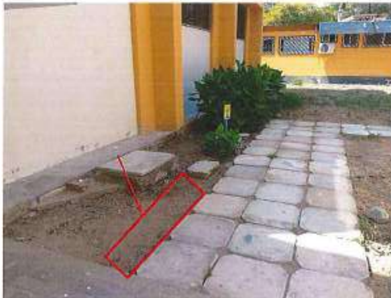
Fotografía 66. Contenedor N°66 de Residuos Sólidos. ENFERMERÍA EDIFICIO 02.
