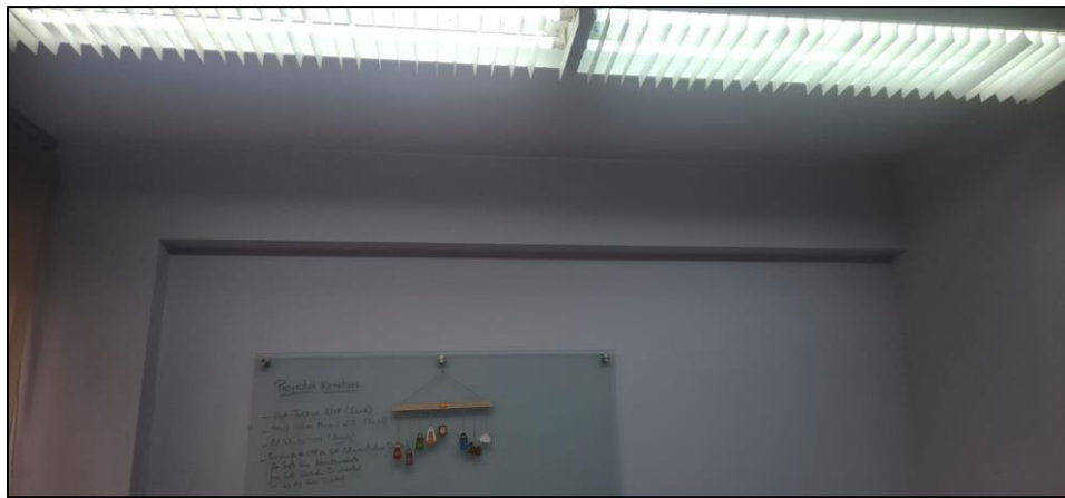
Ilustración 1. SUBGERENCIA LEGAL - INSTALACIÓN NUEVA
