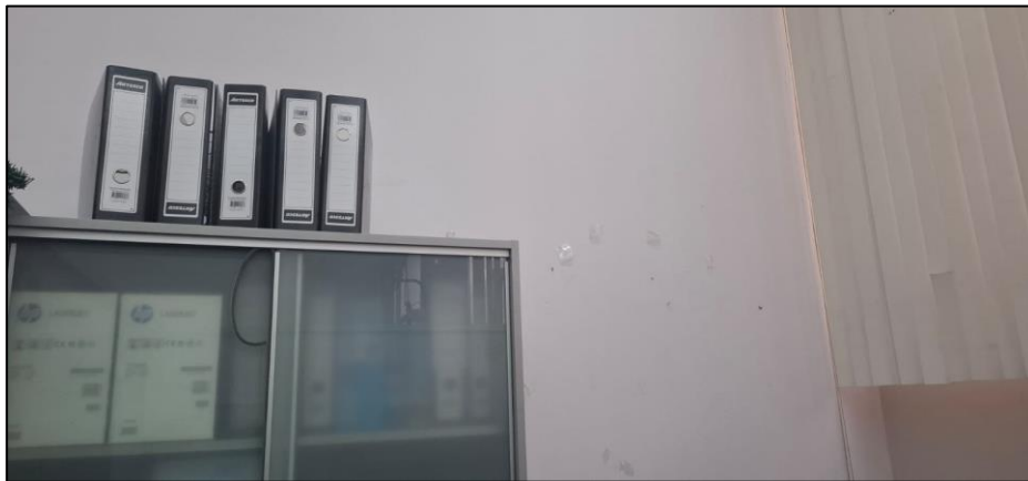
Ilustración 4. DPTO DE GESTION DE BENEFICIOS PREVISIONALES- INSTALACION NUEVA
