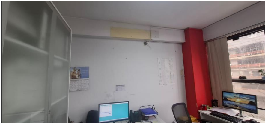
Ilustración 3. DPTO DE DSI - INSTALACION NUEVA
