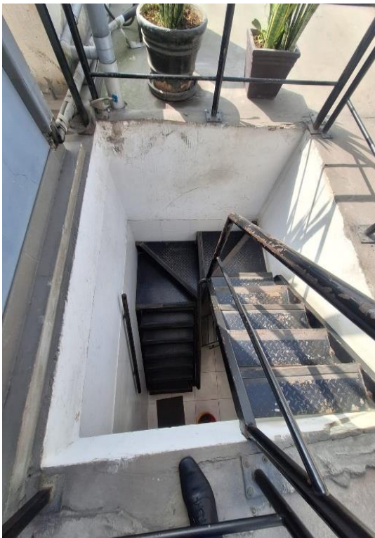
Imagen N°14: En la imagen se observa la estructura de la escalera tipo L. Se evidencia corrosión en las barandas y en la estructura de cobertura, por lo que es necesario ejecutar los procedimientos definidos en la especificación técnica correspondiente a la partida.
