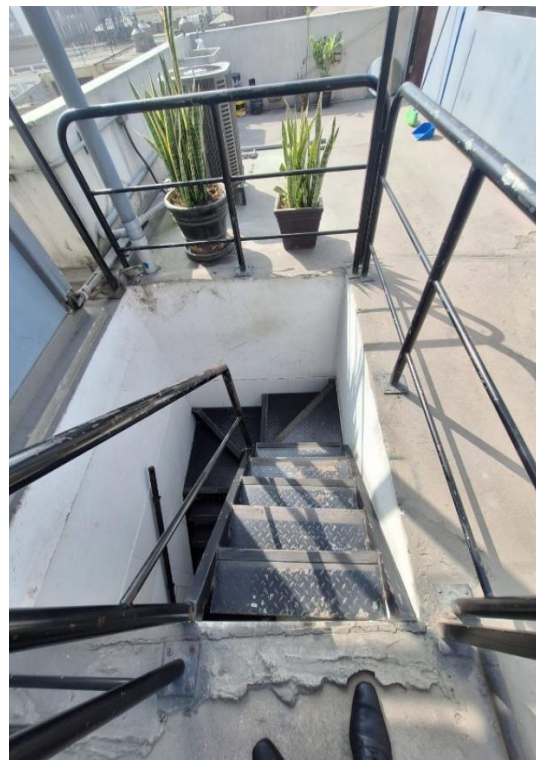
Imagen N°14: En la imagen se observa la estructura de la escalera tipo L. Se evidencia corrosión en las barandas y en la estructura de cobertura, por lo que es necesario ejecutar los procedimientos definidos en la especificación técnica correspondiente a la partida.
