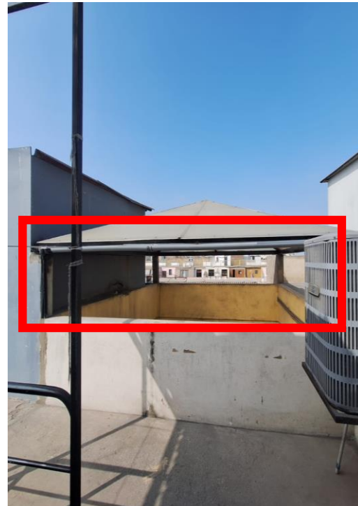
Imagen N°10: En la imagen se muestra el área donde se realizará la instalación de las barandas de 0.53 m en material de acero inoxidable. La baranda será fabricada en acero inoxidable AISI 304 o equivalente. Los parantes estarán conformados por tubos circulares Ø 3" (poste principal) y Ø 2" (traviesa horizontal). Para el anclaje se emplearán planchuelas de acero inoxidable, así como pernos y fijaciones de acero inoxidable que garanticen su correcta sujeción y seguridad. El metrado correspondiente a la partida es de 4.00 m .
