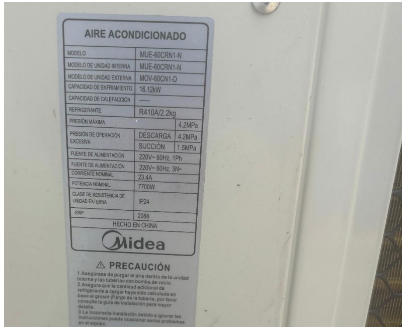
IMAGEN 05: Placa del equipo de aire acondicionado
