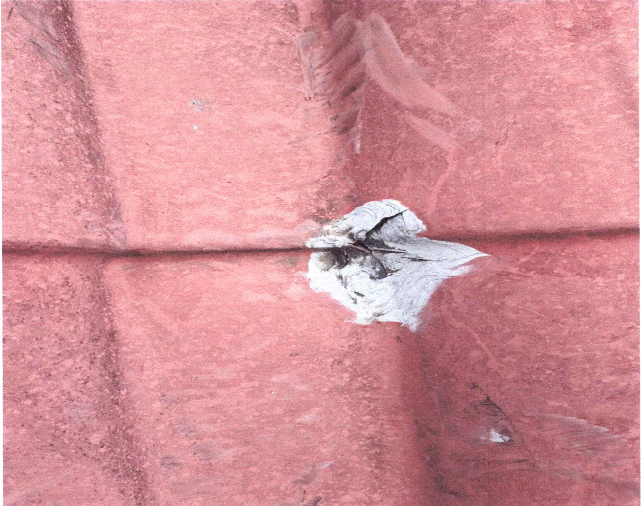
Techo de Almacén de Patrimonio de la UGEL Bambamarca
