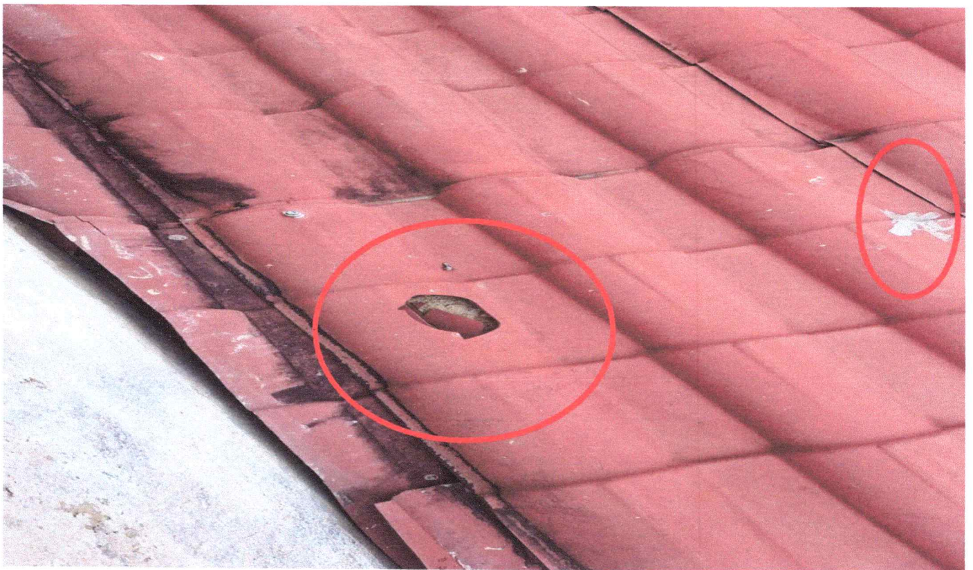
Techo del auditorium de la UGEL Bambamarca
