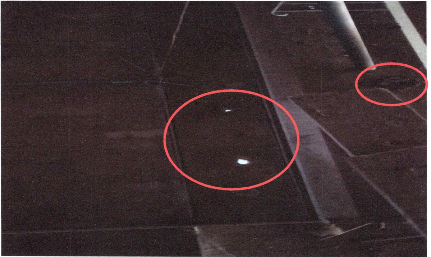
Techo del auditorium de la UGEL Bambamarca
