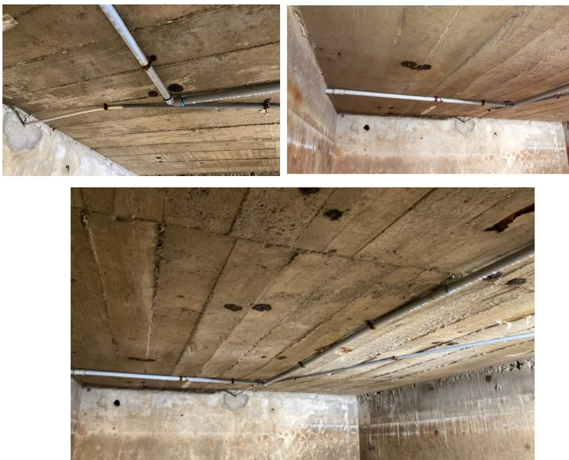
Imagen 4: Interior de la cisterna, se aprecia tubería de agua de PVC adosada en el techo de la cisterna, requiere reubicación.
