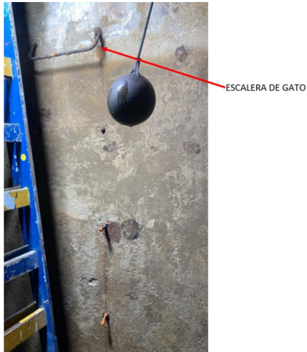
Imagen 10: Interior de la cisterna, pasos de escalera de fierro tipo gato , en mal estado, requiere retiro y resane de pared.
