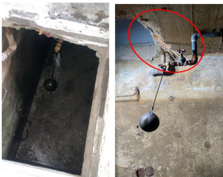
Imagen 4: Interior de la cisterna, se aprecia tubería de agua de PVC adosada en el techo de la cisterna, requiere reubicación.
