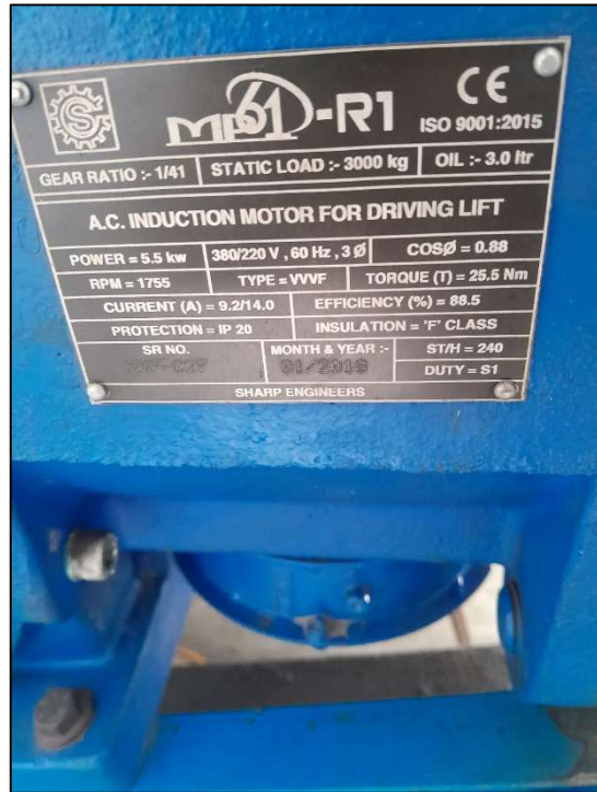
Placa de motor de Ascensor
