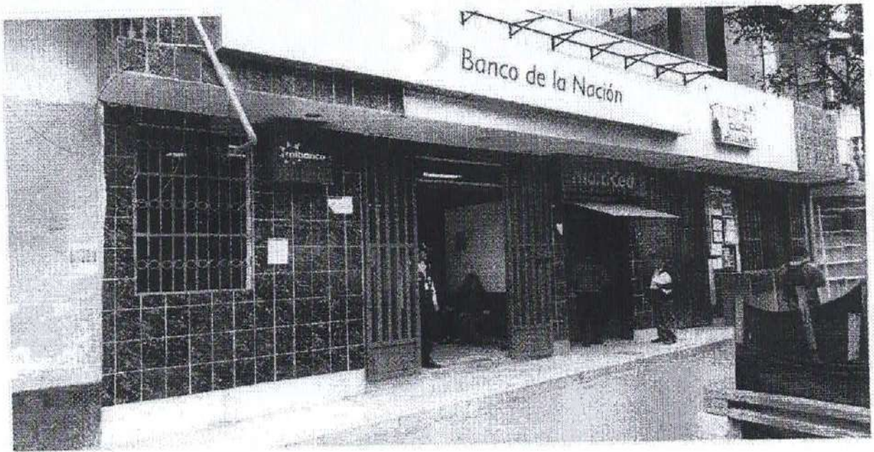
Imagen 3: Cajero existente CE-1 en la Agencia Pomabamba, se demolerá el muro donde está el cajero automático, se retirará la visera, el letrero, se hará un nuevo muro de concreto de h=0.15 según plano E-1 y se colocará vinil nuevo, según plano A-4. Se retirará el enchape verde de la fachada, luego se tarrajeará, empastará y se pintará con pintura látex gris oriente 1:2, según plano I-2 y A-2.
