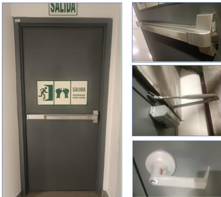
Figura 07: Puertas cortafuego certificadas
