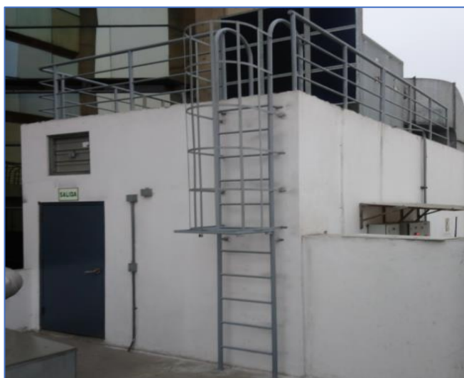
Figura 04: Barandas y escalera de acceso a sistema de presurización de escaleras
