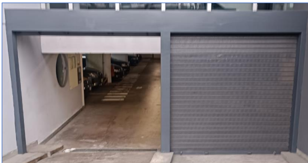
Figura 06: Puertas enrollables de acceso vehicular
