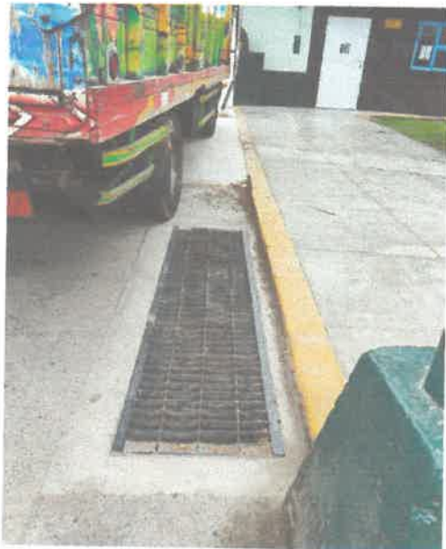
Se muestra el drenaje por la Comisaría de la Plaza de Armas con presencia de residuos sólidos.
