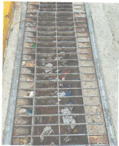
Se muestra el drenaje por la Comisaría de la Plaza de Armas con presencia de residuos sólidos.
