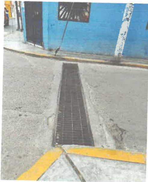
Por la calle Reforma y altura de la caja Trujillo, se muestra el estado actual del drenaje y el hundimiento de la carpera asfáltica a la altura de la caja Trujillo.
