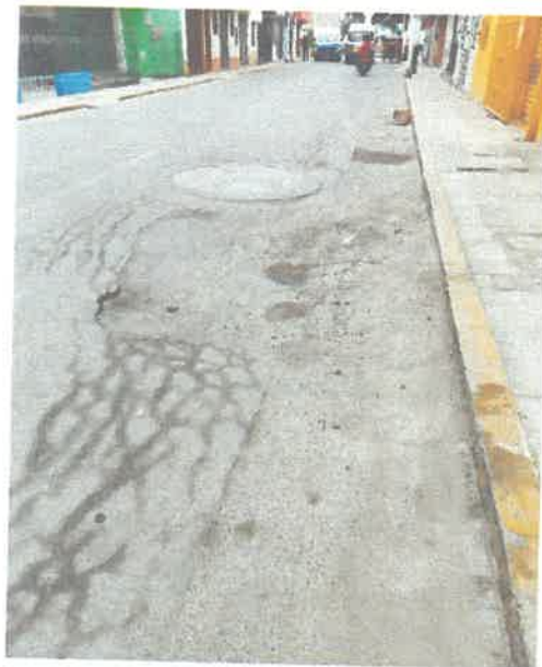
Por la calle Reforma y altura de la caja Trujillo, se muestra el estado actual del drenaje y el hundimiento de la carpera asfáltica a la altura de la caja Trujillo.
