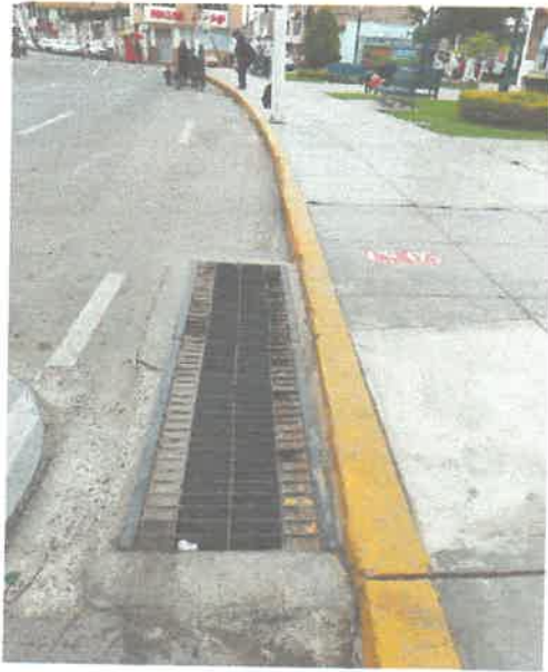
Plaza de Armas altura del arco también de muestra residuos sólidos dentro del drenaje.
