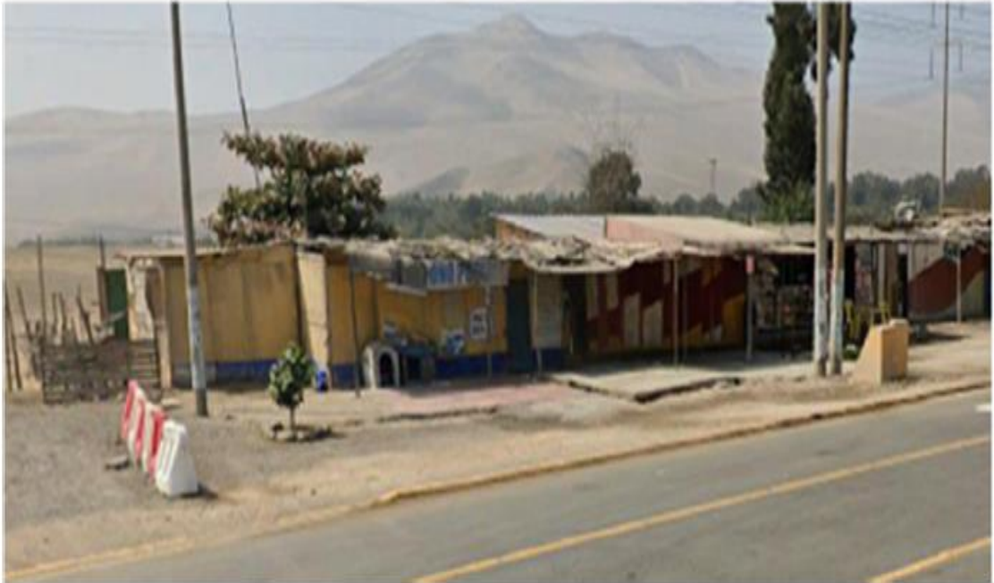
Fotografía 1. Inicio del área de ocupación de viviendas y locales comerciales de terceros
