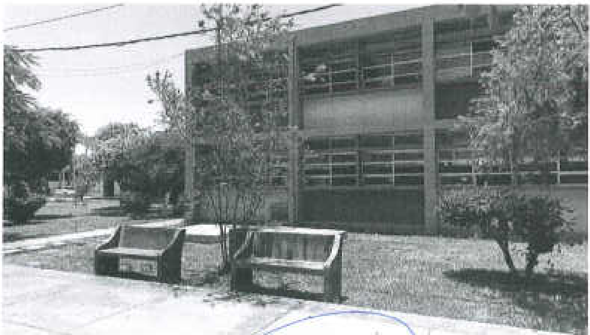
FOTOGRAFIA 02: UBICACIÓN DE LA INSTALACION DE PLACAS N2-SERVICIO DE TECHOS
