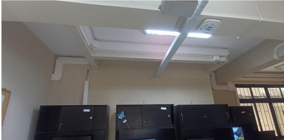
CARA 1 – Condiciones del muro de tabiquería seca existente.
