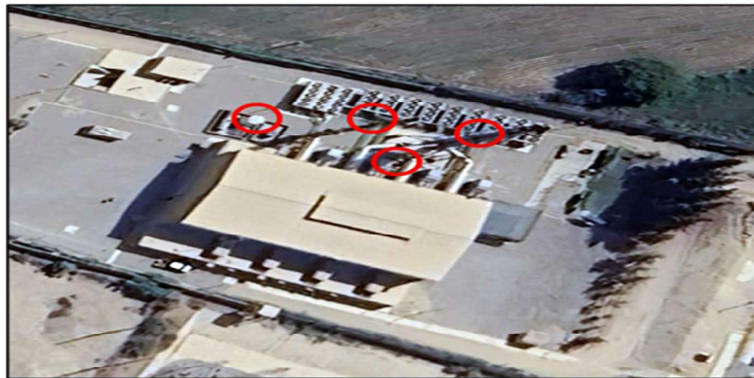
Figura 1 Ubicación de 04 chimeneas en la CT Independencia
