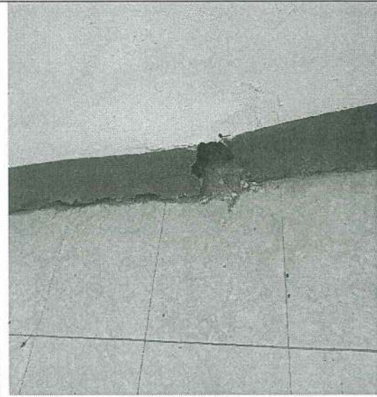
FOTO 06: zócalo Deteriorado.
