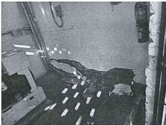
FOTO 11 y FOTO 12: se muestra el estado de la pared en el ambiente donde se ubica el Grupo electrógeno
