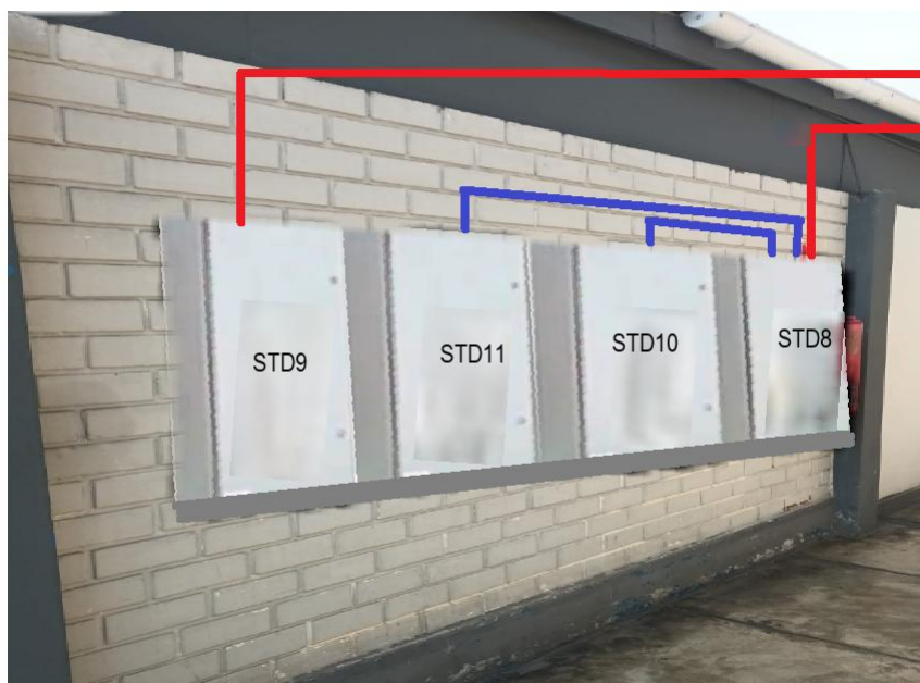
Imagen Instalación de tableros eléctricos en pared
