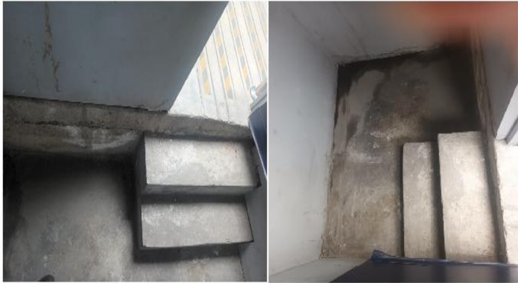
Imagen Escalera de concreto
