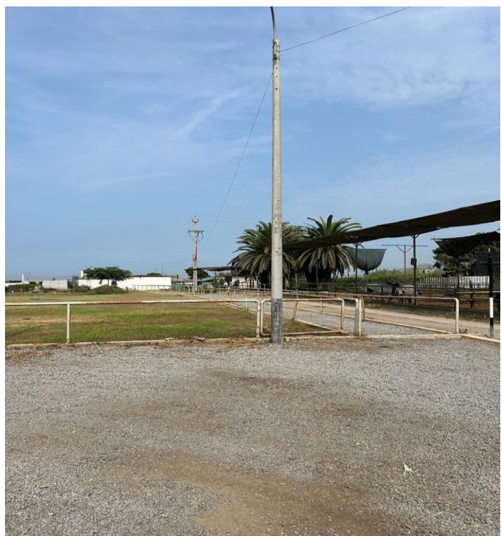
Barandas metálicas para mantenimiento de pintura
