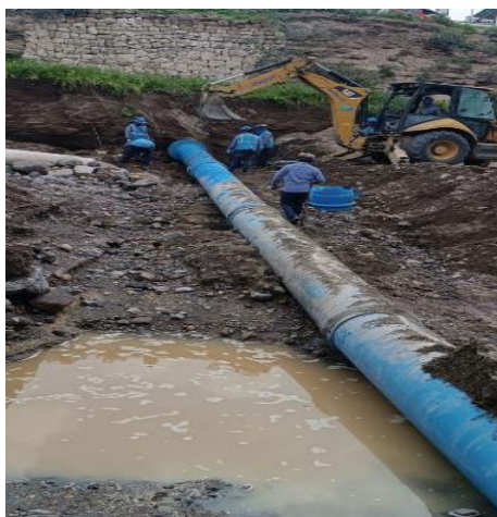
Imagen 2: Reposición de tubería
