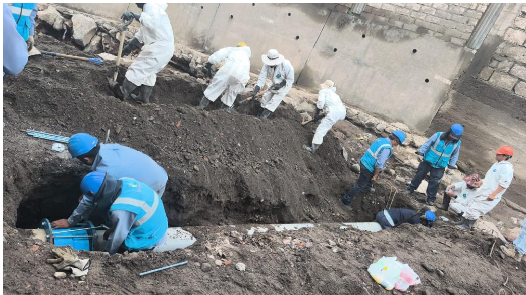
Ilustración 2. Reparación de tubería
