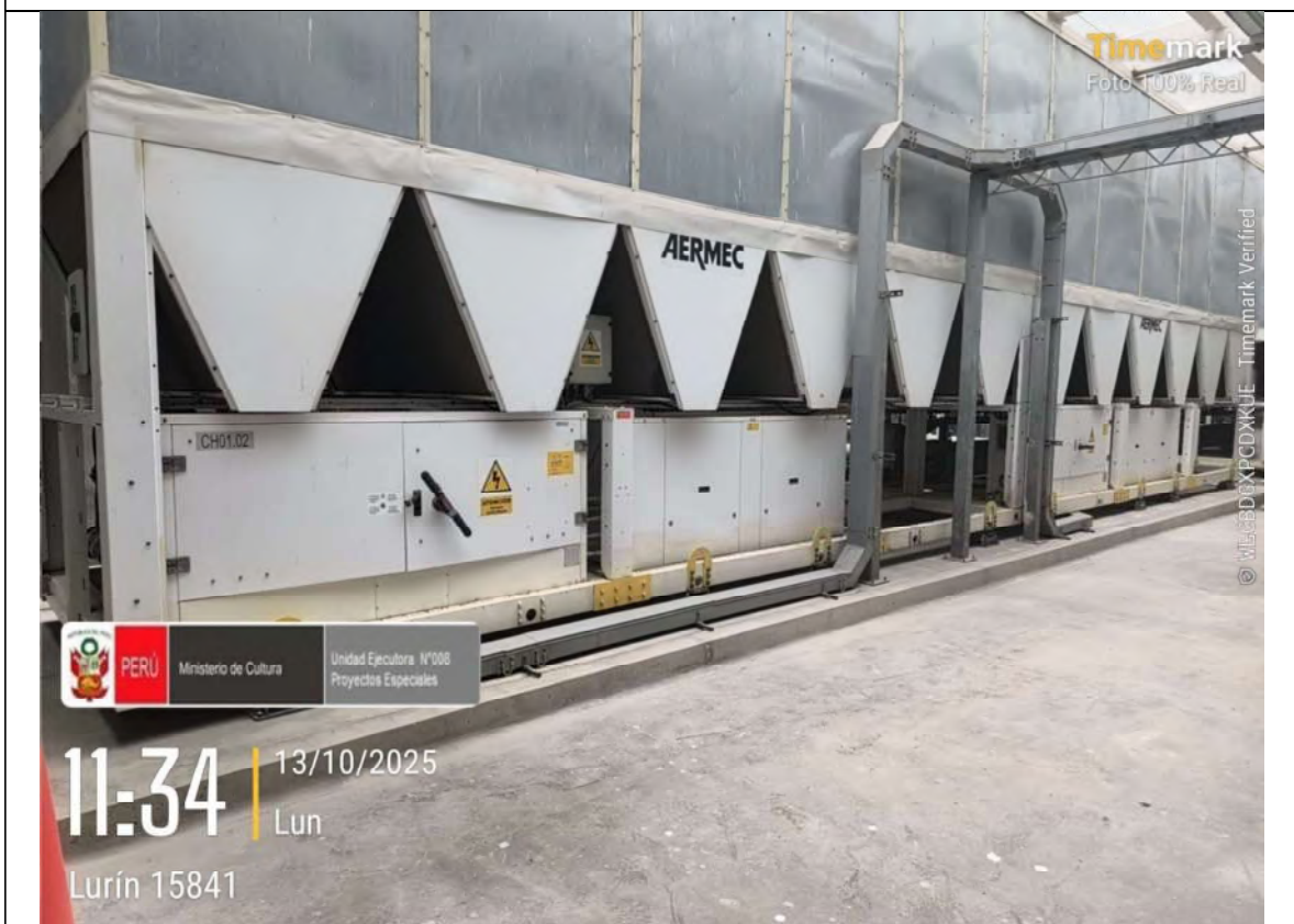
Imagen N° 06: Equipo Chiller's CH01.02
