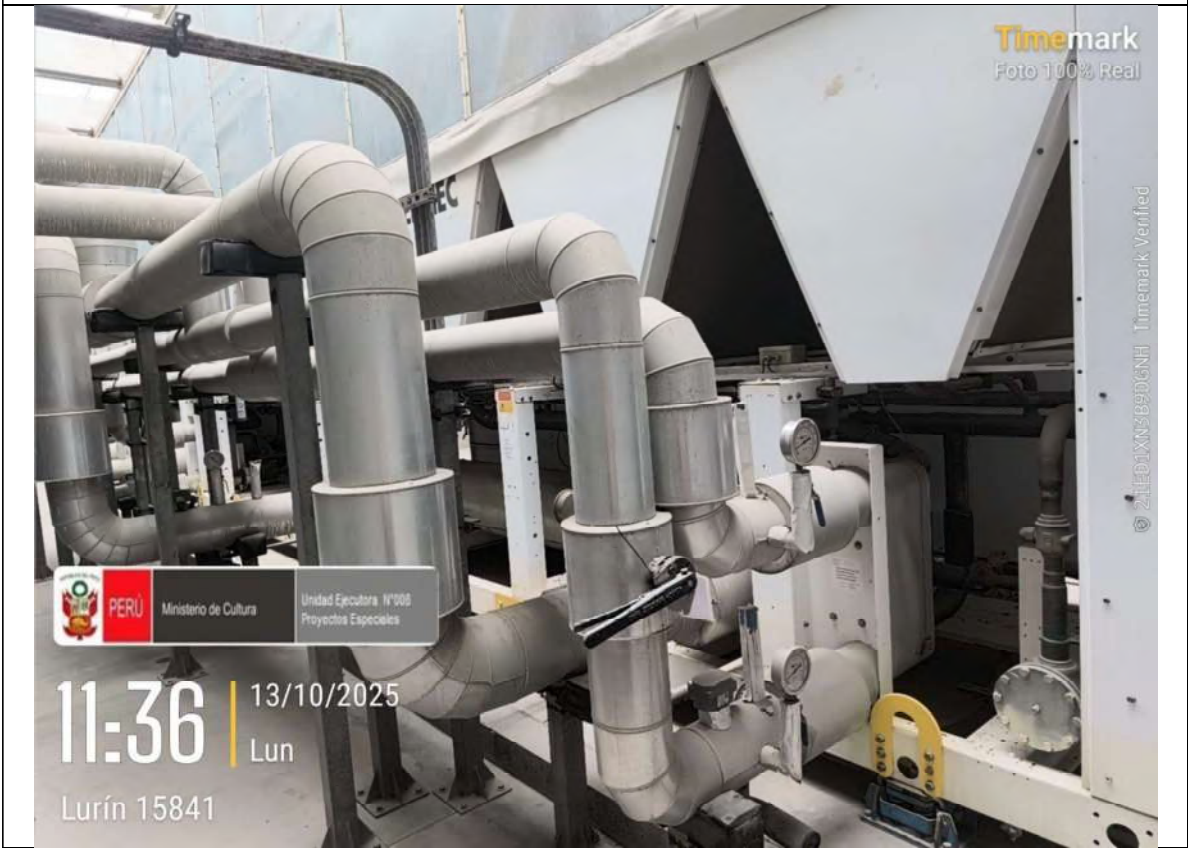
Imagen N° 08: Equipo Chiller's CH01.02
