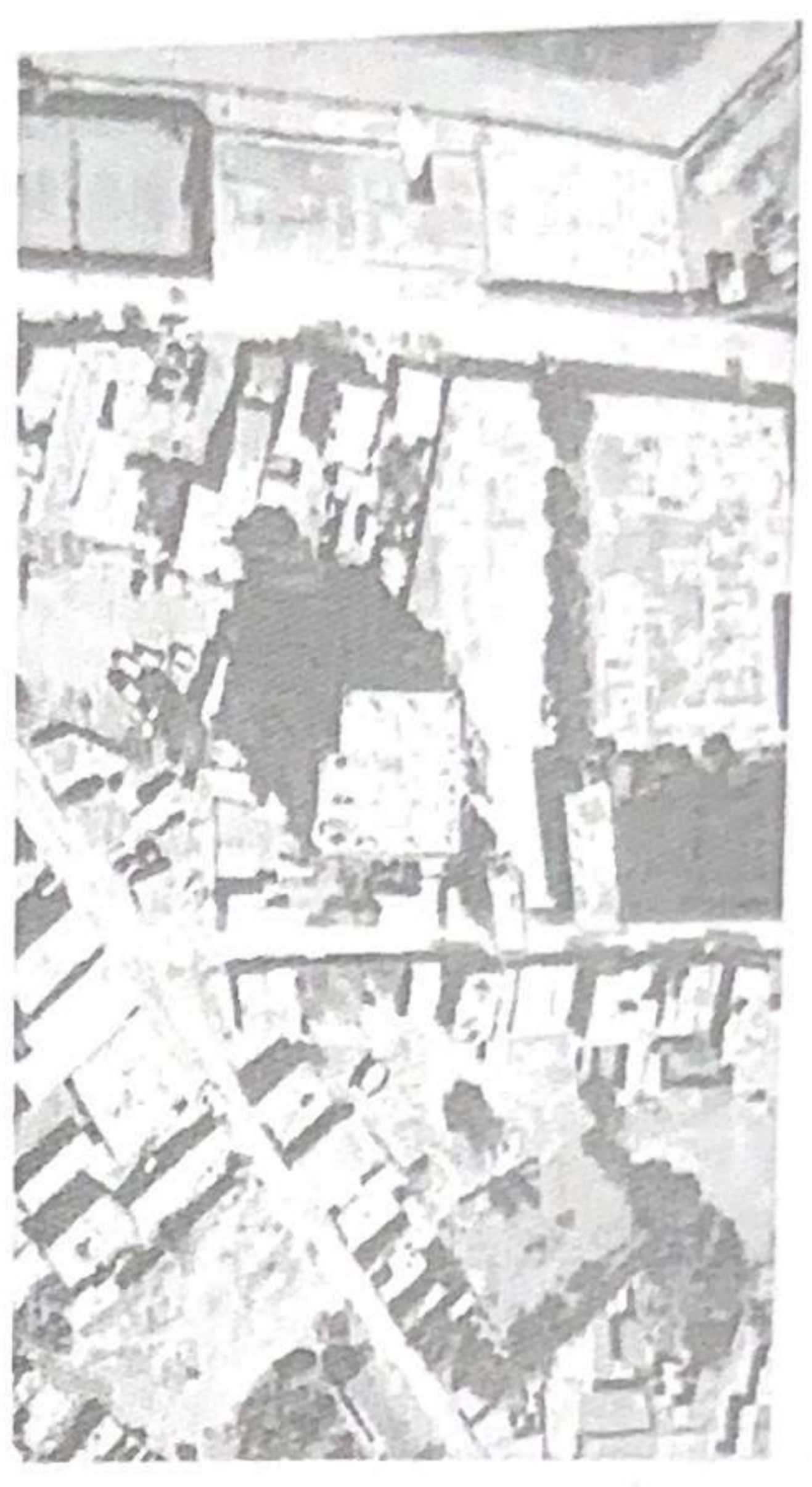
Fotografía 1: Visto de la ubicación de la edificación de almacén de Medicamentos de SISMED y Cadena de Frio, evaluado cumple Norma Técnica de Salud 132-MINSA/2015
