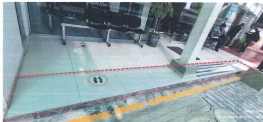
IMAGEN: RETIRO DE PISO – APERTURA DE GRADERIA
