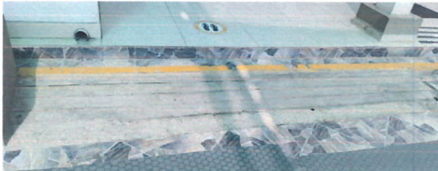
IMAGEN: RAMPA EXISTENTE
