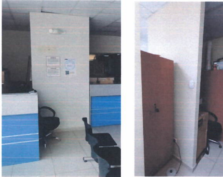
IMAGEN: MUROS POR RETIRAR
