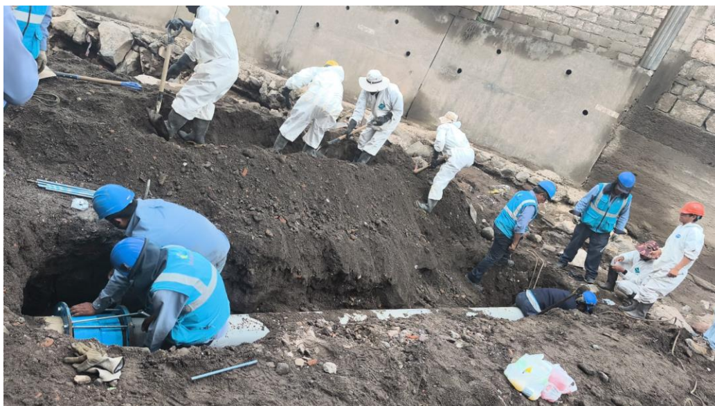
Ilustración 2. Reparación de tubería
