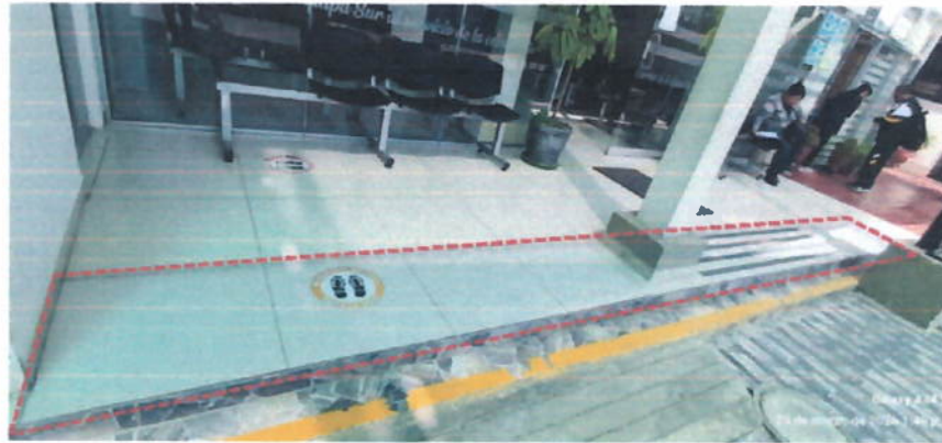
IMAGEN: RETIRO DE PISO – APERTURA DE GRADERIA
