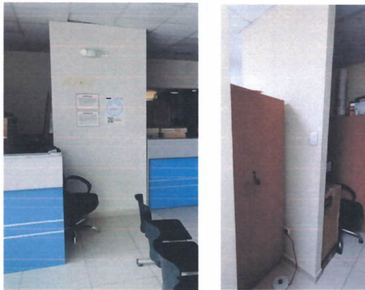
IMAGEN: MUROS POR RETIRAR
