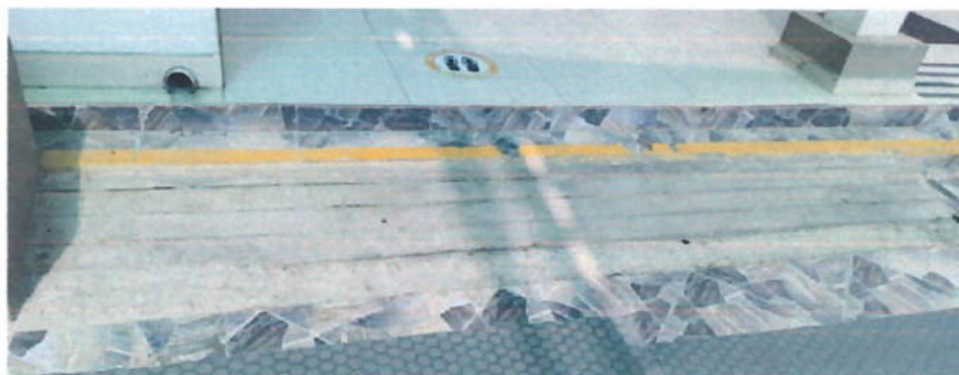
IMAGEN: RAMPA EXISTENTE
