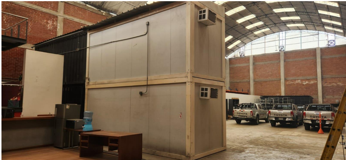
Contenedores de 20 pies y de dos (02) módulos con tabiques y techos de paneles PUR y cobertura TR4.
