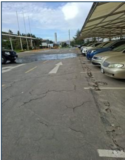
Imagen 07: Imagen estado actual
