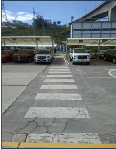
Imagen 01: Imagen estado actual
