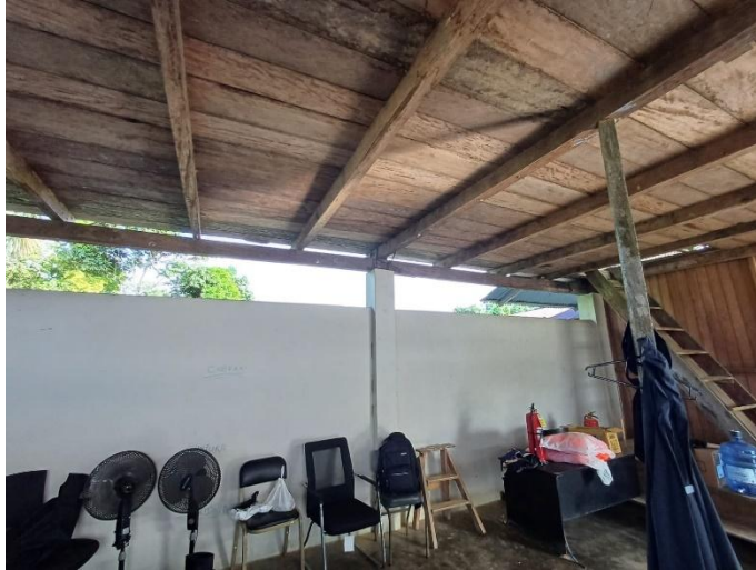
Foto 07: Vanos libres donde se instalarán las mallas mosquiteras.
