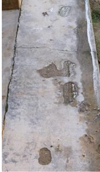
Foto 09: Resane de pisos y pavimentos en sede del MP - Yutupis
