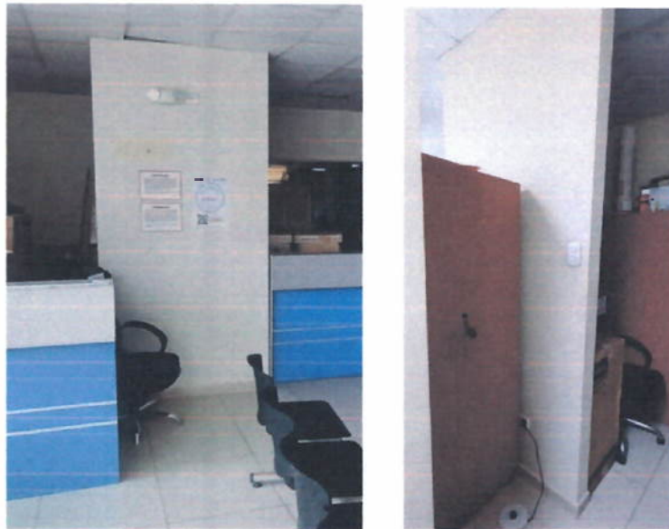
IMAGEN: MUROS POR RETIRAR
