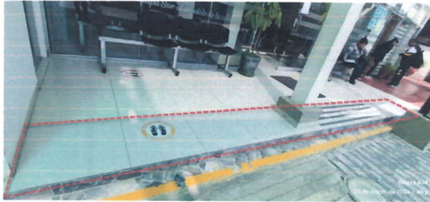
IMAGEN: RETIRO DE PISO – APERTURA DE GRADERIA
