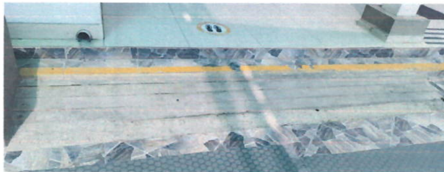
IMAGEN: RAMPA EXISTENTE
