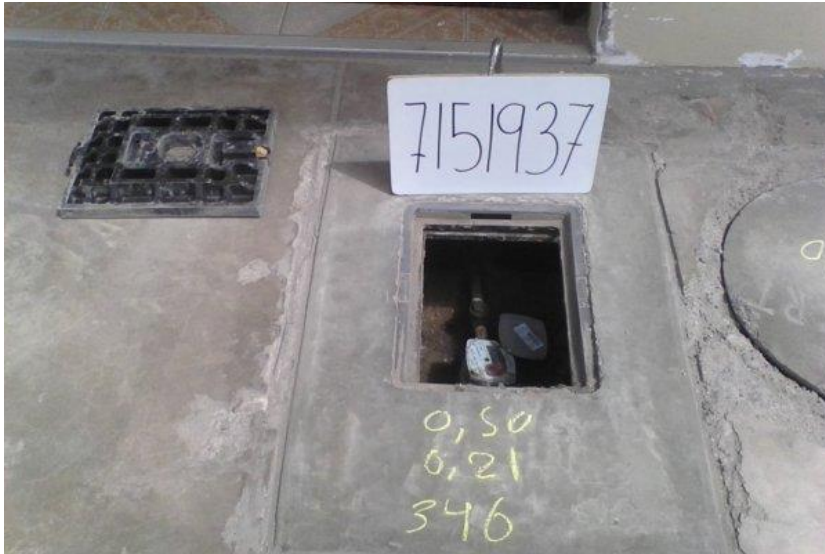
FOTO 01: CONEXIÓN DE AGUA
