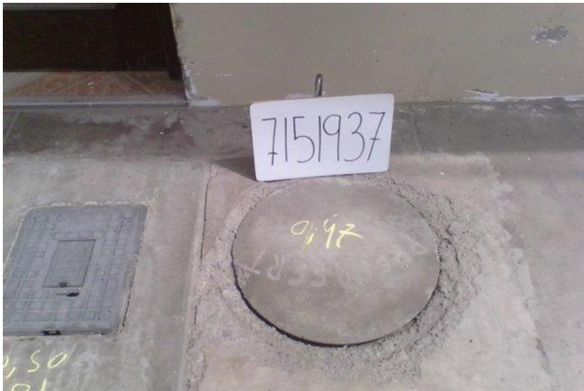
FOTO 02: CONEXIÓN DE ALCANTARILLADOD
