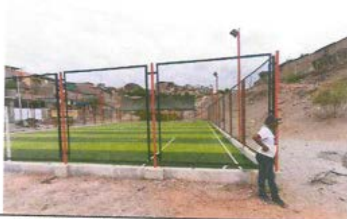
MANTENIMIENTO DE INFRAESTRUCTURA EN ZONAS DE ESPECTACION DE CAMPO DEPORTIVO FRANCISCO BOLOGNESI
