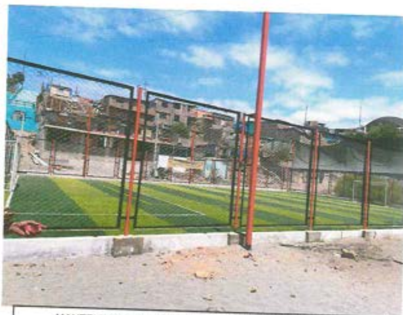
MANTENIMIENTO DE INFRAESTRUCTURA EN ZONAS DE ESPECTACION DE CAMPO DEPORTIVO FRANCISCO BOLOGNESI
