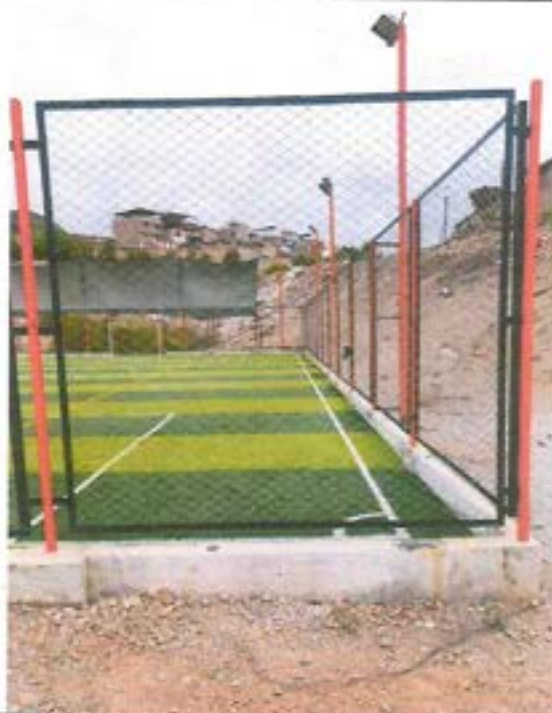
MANTENIMIENTO DE INFRAESTRUCTURA EN ZONAS DE ESPECTACION DE CAMPO DEPORTIVO FRANCISCO BOLOGNESI
