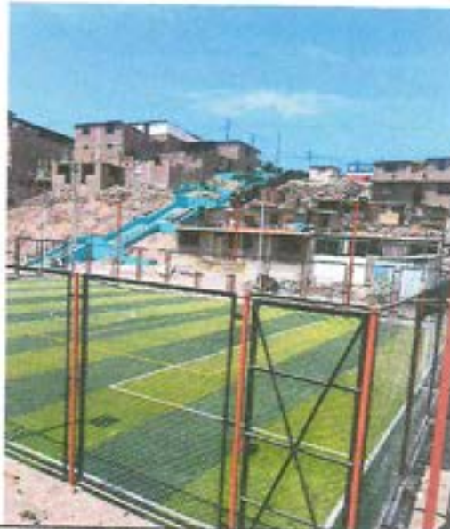
MANTENIMIENTO DE INFRAESTRUCTURA EN ZONAS DE ESPECTACION DE CAMPO DEPORTIVO FRANCISCO BOLOGNESI
