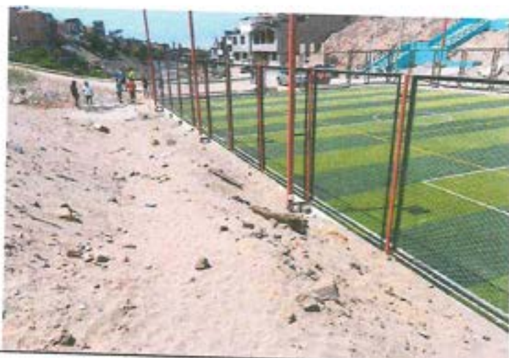
MANTENIMIENTO DE INFRAESTRUCTURA EN ZONAS DE ESPECTACION DE CAMPO DEPORTIVO FRANCISCO BOLOGNESI
