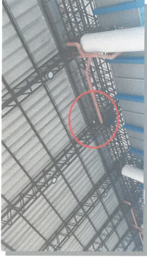
Presencia de vacíos en juntas de las canaletas con la cobertura
