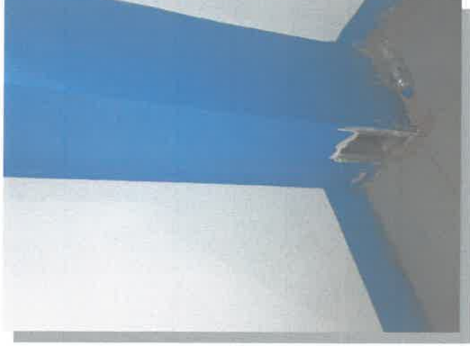
Presencia de vacíos en juntas de las canaletas con la cobertura
