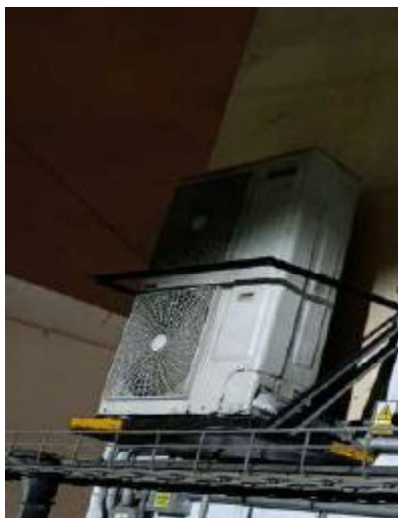
Imagen N°01.- Vista del equipo a desmontar.
