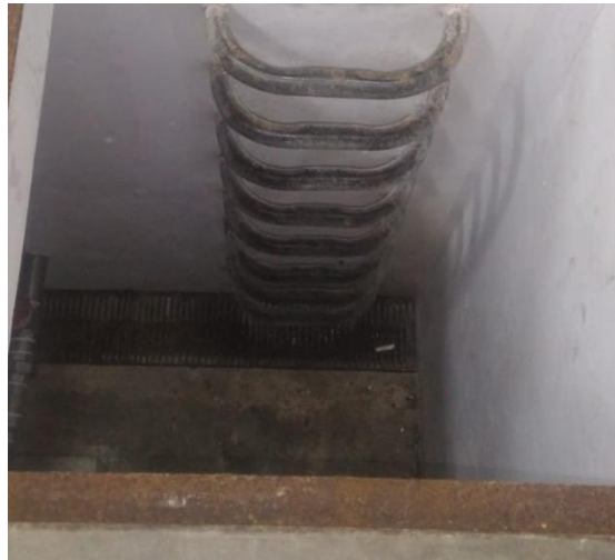
Imagen 16: escalera empotrada existente.
